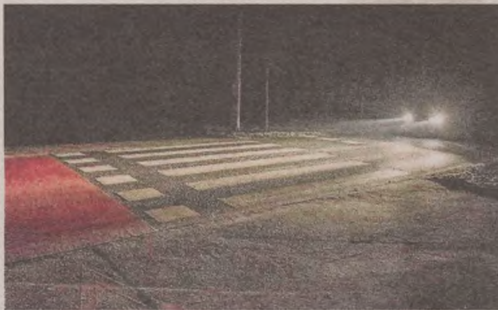
► Tak wyglądają teraz oba przejścia dla pieszych na ul. Arciszewskiego w kierunku Krępy Słupskiej. Zarząd Infrastruktury Miejskiej zapewnia, że awaria oświetlenia zostanie niebawem usunięta
