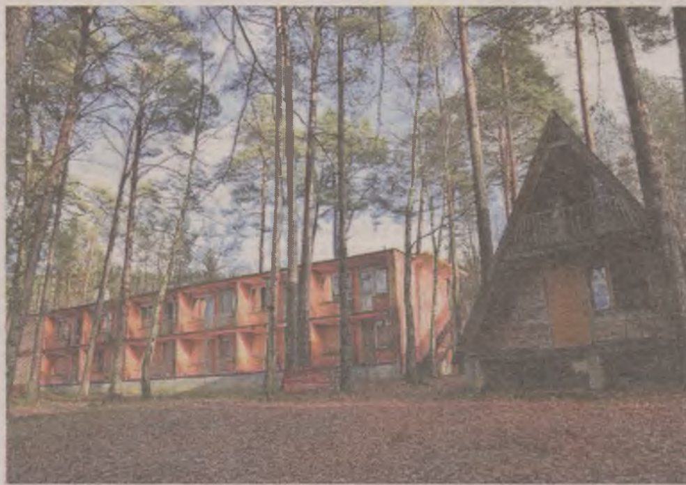
► Ośrodek Wypoczynkowy Sobótki w Obłężu jest położony w lesie nad brzegiem jeziora. Obiekt zajmuje obszar ponad dwóch hektarów
