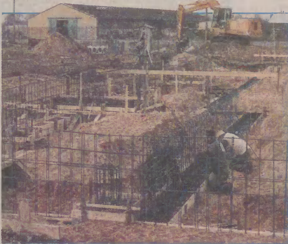
Na terenie budowy trwają obecnie roboty ziemne.
