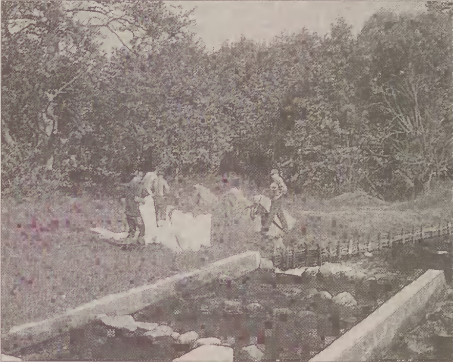
W Bożance, gm. Trzebielino, trwa budowa nowego Ośrodka Hodowlanego Ryb Łososiowatych.
