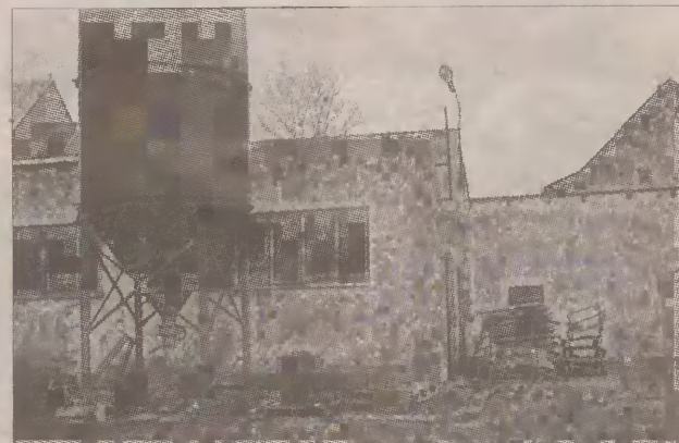
Budynek betoniarni jest pusty, tylko powybijane szyby świadczą o tym, że ktoś tu bywa.
