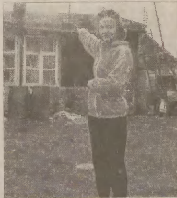
Konstrukcja pochyliła się i przy silniejszym wietrze może runąć pokazuje pani Wanda.
