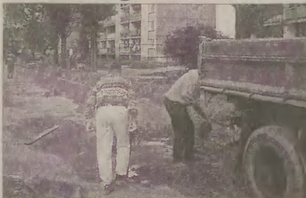
Pracom przy remontach dróg sprzyja wiosenna pogoda.
