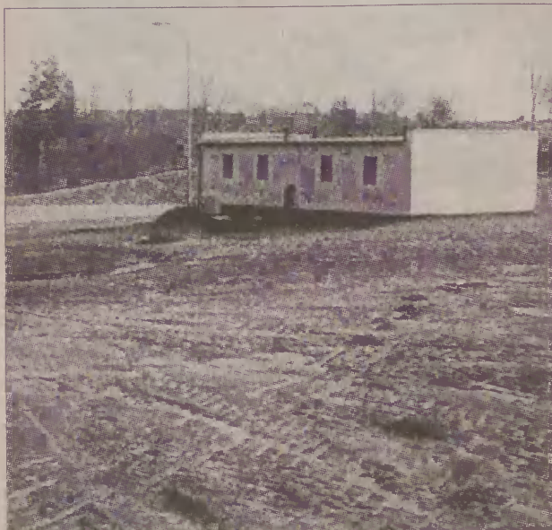
Tak wygląda jedna z najnowocześniejszych inwestycji ekologicznych - oczyszczalnia ścieków w Skórowie.
