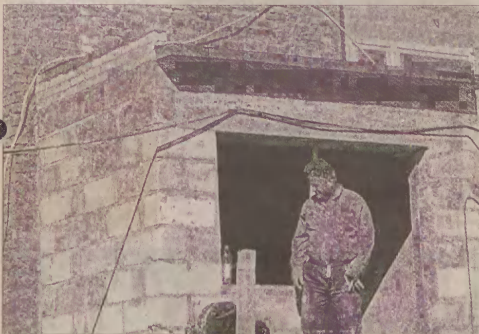
Roman Gawlik, szef firmy budowlanej, która obecnie kończy tynkowanie drugiego segmentu bloku przy ul. Wojska Polskiego nadzoruje budowę.
