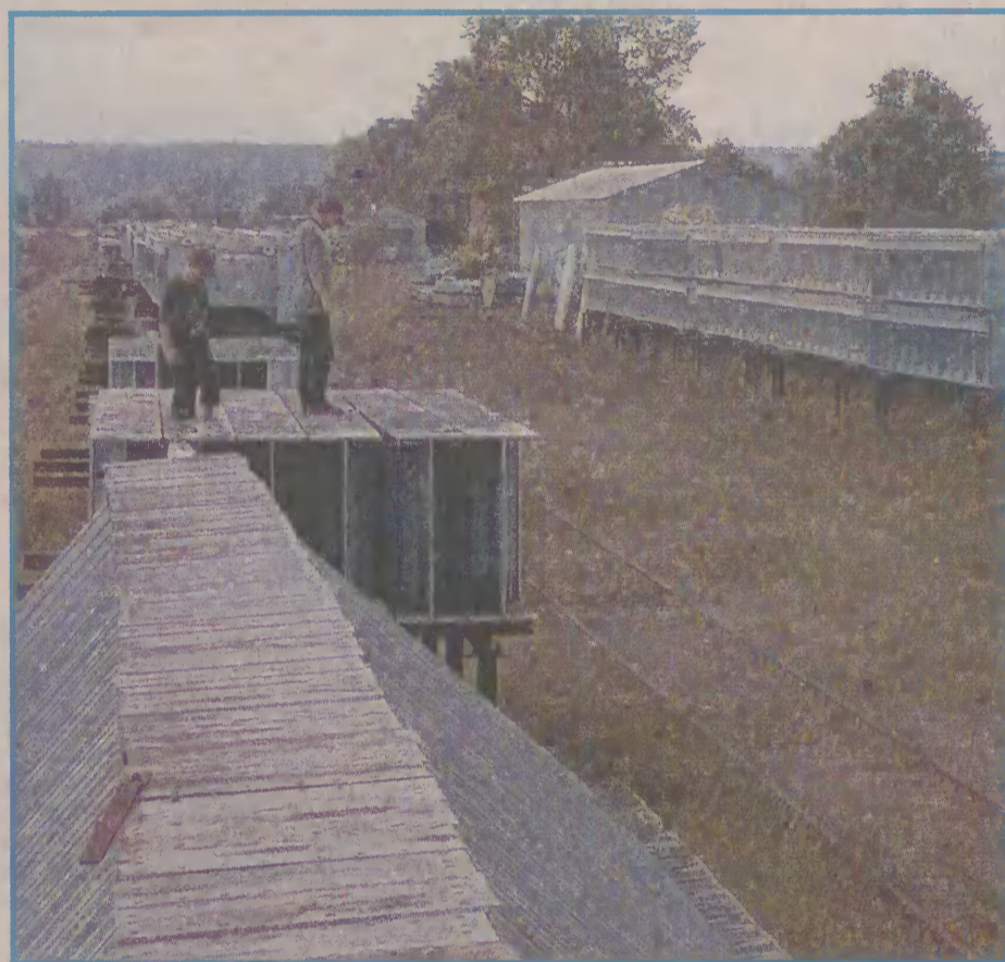
Elementy mostu leżą na bocznicie w Nowym Dworze Kwidzyńskim od blisko 30 lat.
