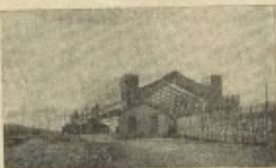
Stacja morska w Cherbourg w budowie.
