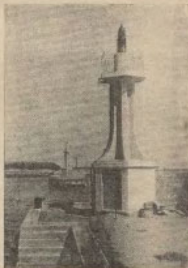
Latarnia wejścia północnego i do basenu południowego
