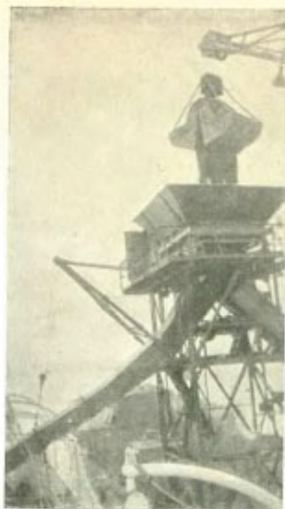
„Niemen” uzupełnia swe zapasy węgla statekowego przy wejściu do kanału Kilońskiego.
