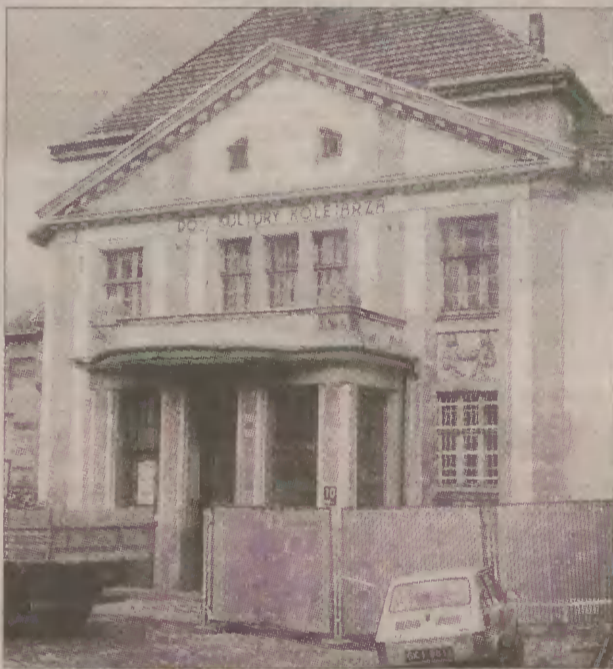
Dawny Dom Kultury Kolejarza jest od kilku lat w remoncie.
