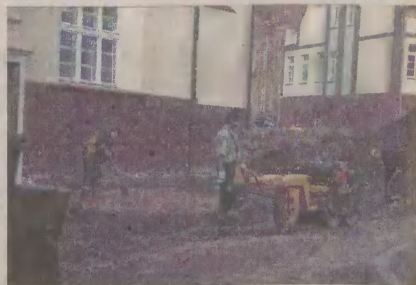
Prace dobiegają już końca.
