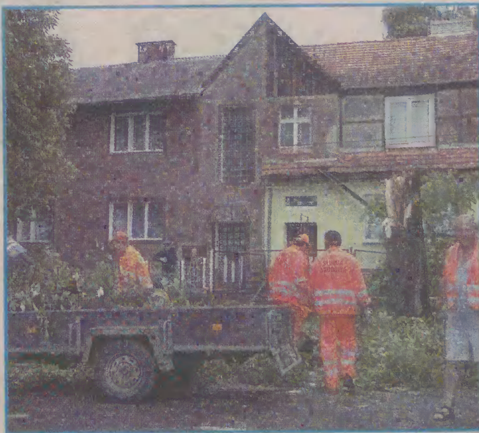
Pracownicy Rejonu Dróg Krajowych usuwali skutki wichury.
