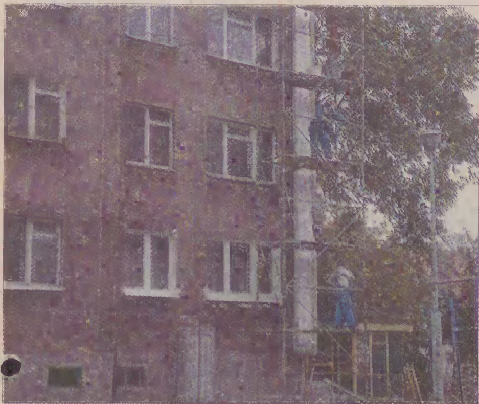
Pracownicy „Pro-budu” instalują rusztowania przy kolejnej ścianie bloku przy ulicy Traugutta.
