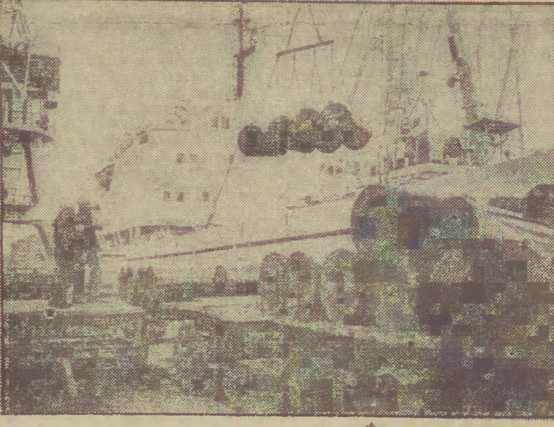
Rozładunek asfaltu ze statku „Grudziądz” przy nabrzeżu Wiślanym w Porcie Gdańskim. Fot. M. Zarzecki
