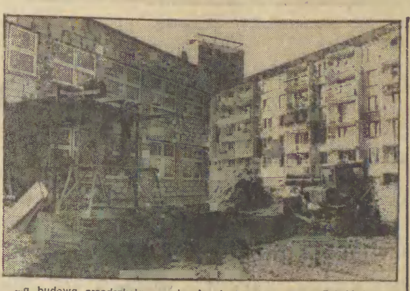
...a budowa przedszkola przeciągała się...
