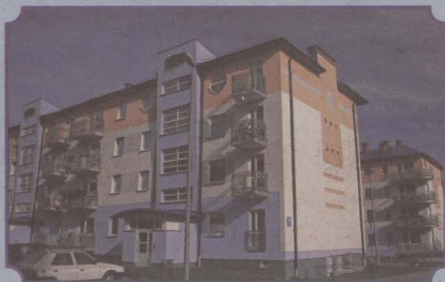
Budowa nowych mieszkań.
