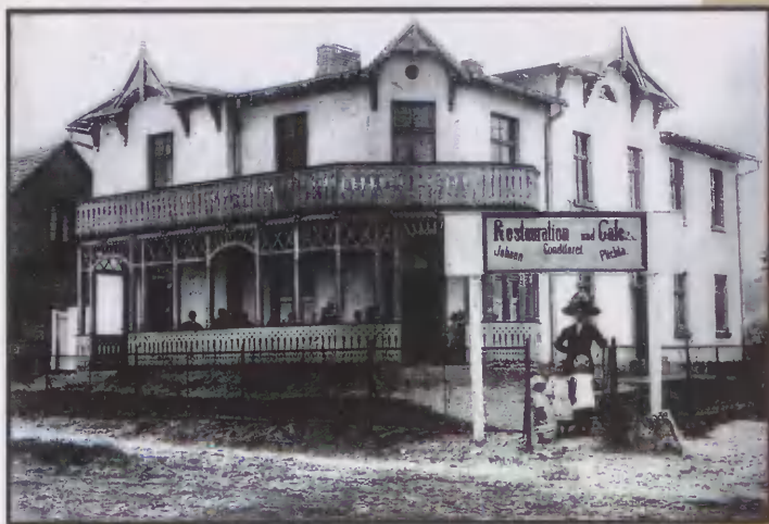
Restauracja A. Plichty. Budynek w miejscu dzisiejszego skweru na rogu ul. 10 Lutego.
