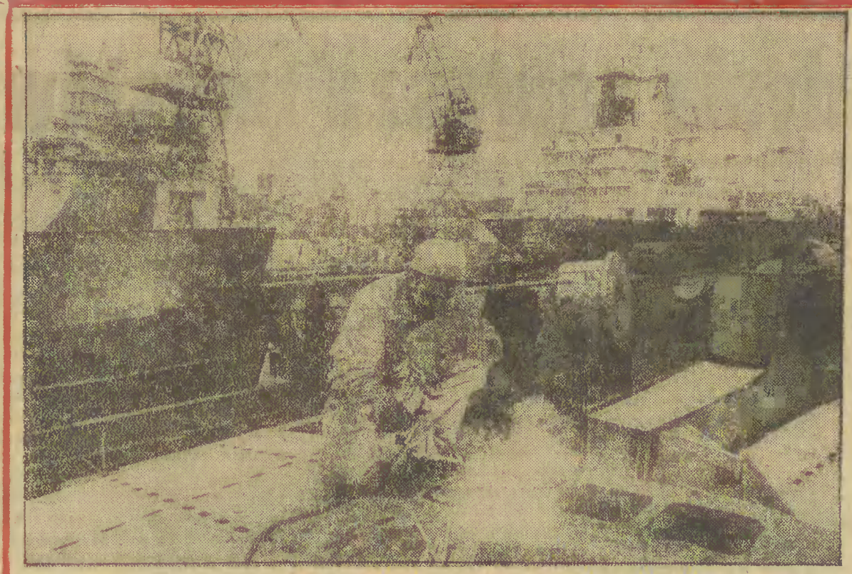
Leszek Przygoda z wydziału przedmontażu K-3 Stoczni im. Lenina w Gdańsku podczas spawania elementu steru budowanej na pochylni jednostki. Fot. M. Zarzecki
