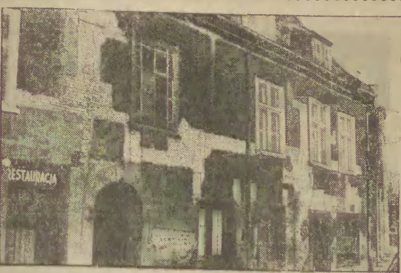
Przy ul. Warkkiej nad Motławą, tuż obok restauracji „Kubicki”, sześciu z wyglądem wymaganym do roli. Z pewnością wymaga ona remondu, a jeżeli nie, to na pewno położenia nowych tynków. W końcu miejsce to również jest liczenie odwiedzane przez turystów. Fot. M. Zarzecki
