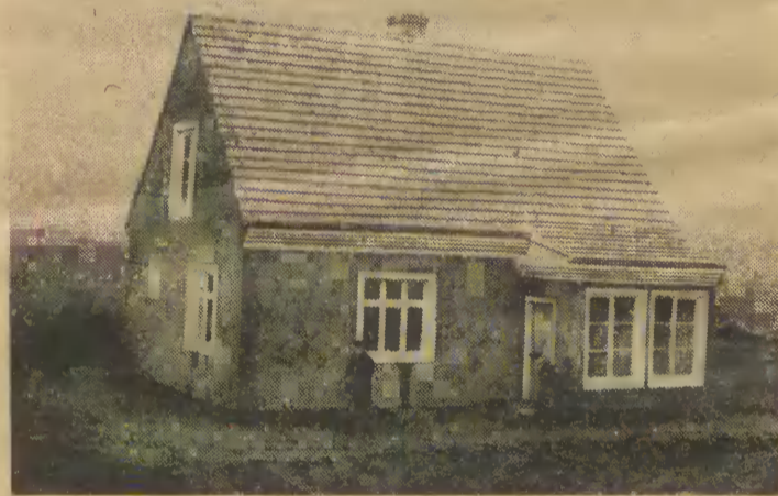
W tym schludnym domku wybudowanym przez żołnierzy Kaszubskiej Jednostki KBW zamieszkała „babcia” Jażdżewska wraz ze swymi bliskimi
