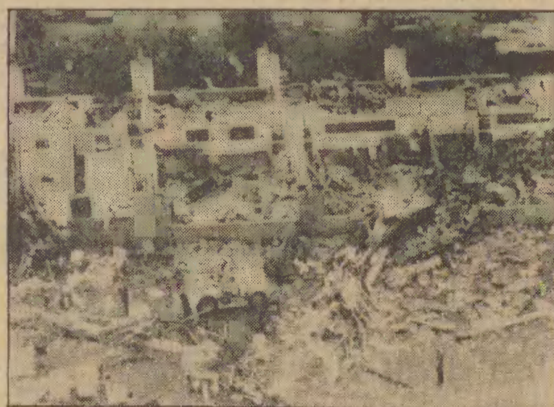
4 bm. nad miejscowością Largo w stanie Floryda przeszło tornado. Najbardziej ucierpiał budynek miejscowej szkoły (na zdjęciu), który został kompletnie rozbity. 2 uczniów poniosło śmierć, a 100 zostało rannych.
