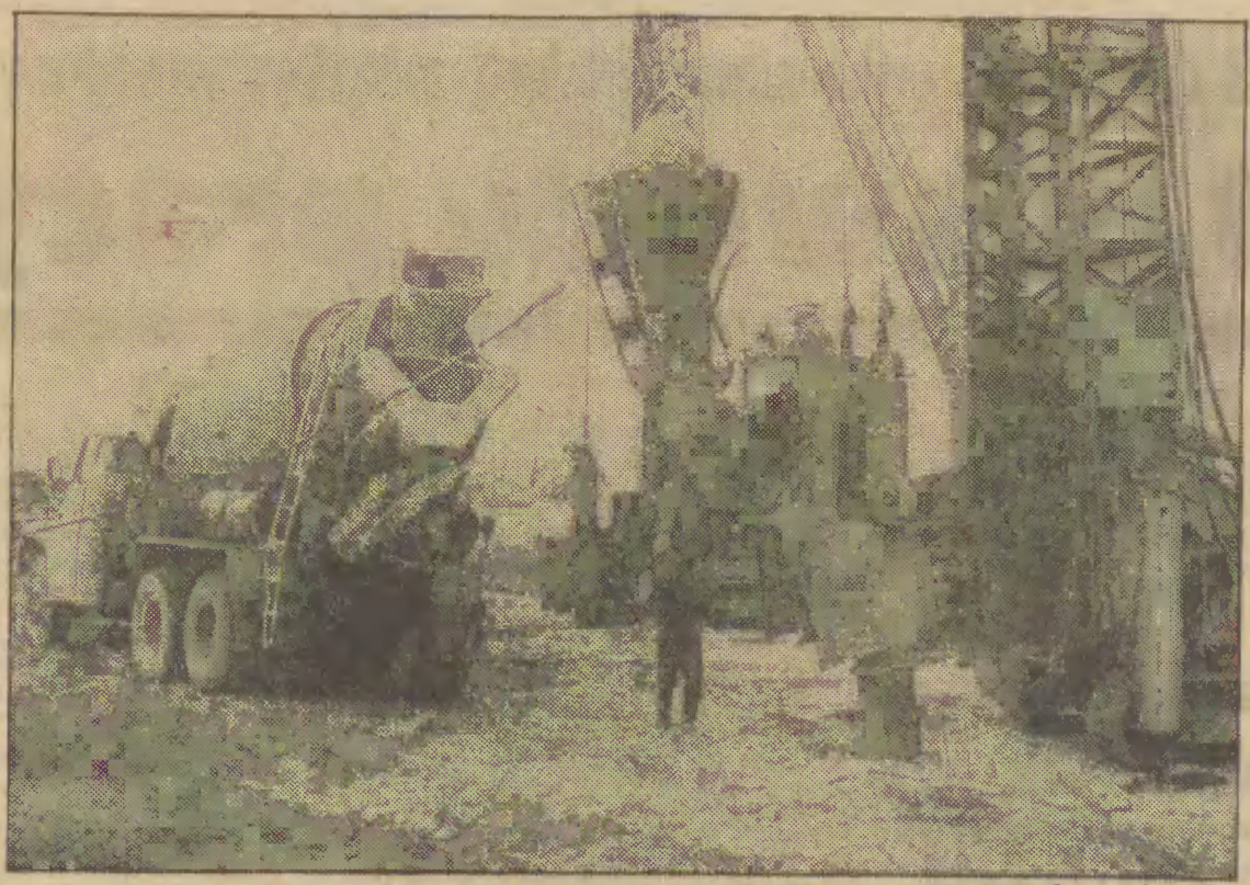
Na terenie budowanej obecnie bazy kontenerowej w Gdyni trwa palowanie dwóch ostatnich sekcji nadbrzeża Halskiego. Prace te nadzoruje inż. Tadeusz Kur z „EnergoPolu-4”, który przewiduje iż dwie brygady katezystów Józefa Bezcowskiego oraz Zbigniewa Zdrojewskiego zakończą roboty palowe do 10 bm. by mogła ruszyć jak najszybciej budowa końcowego fragmentu nadbrzeża. Na zdjęciu: brygada J. Bezcowskiego podczas zalewania cementem wbitego uprzednio pola. Fot. M. Zarzecki
