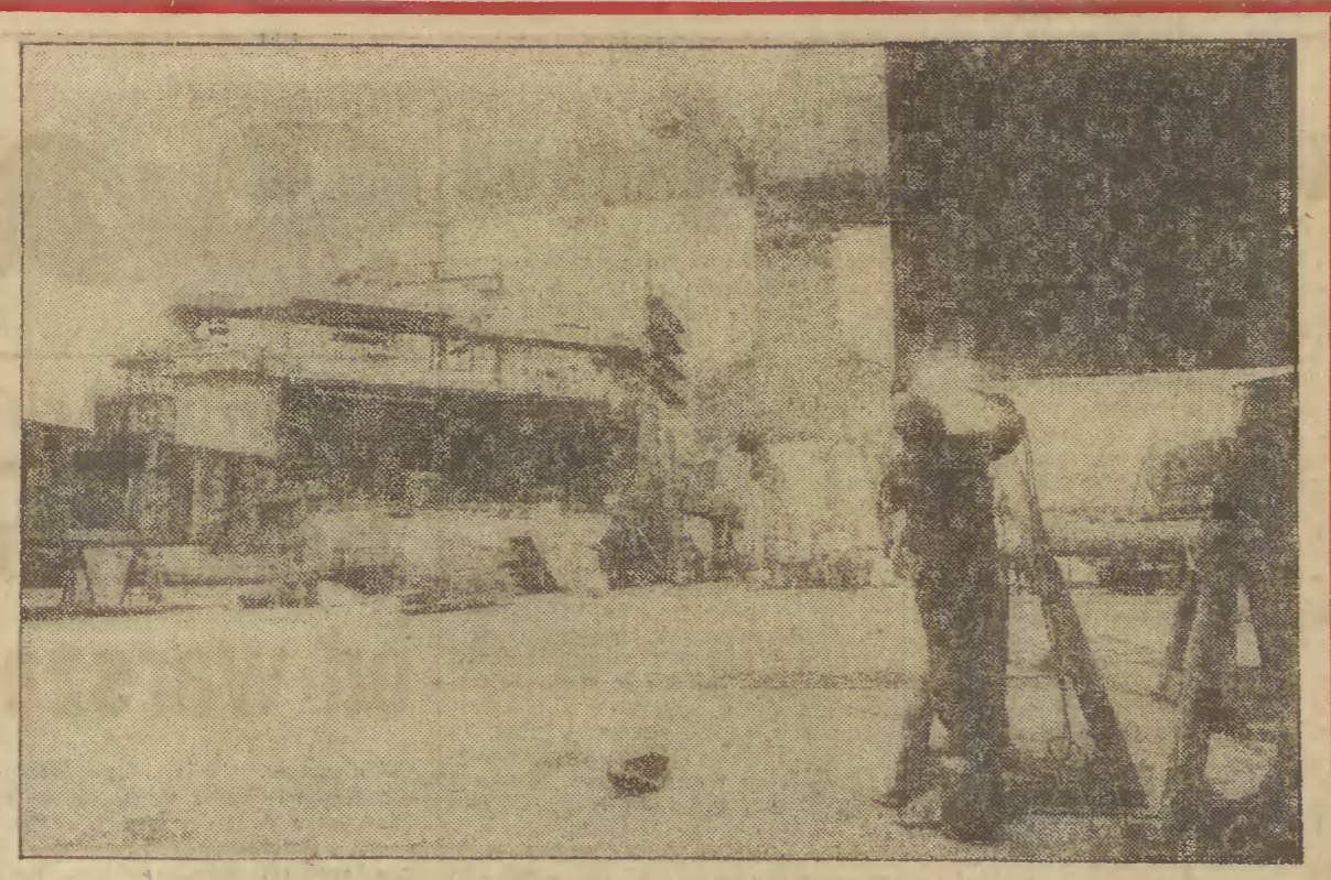
W II suchym doku Stoczni im. Komuny Paryskiej w Gdyni powstają kolejne statki typu ro-ro, samochodowicy dla armatorów zagranicznych. Fot. M. Zarzecki
