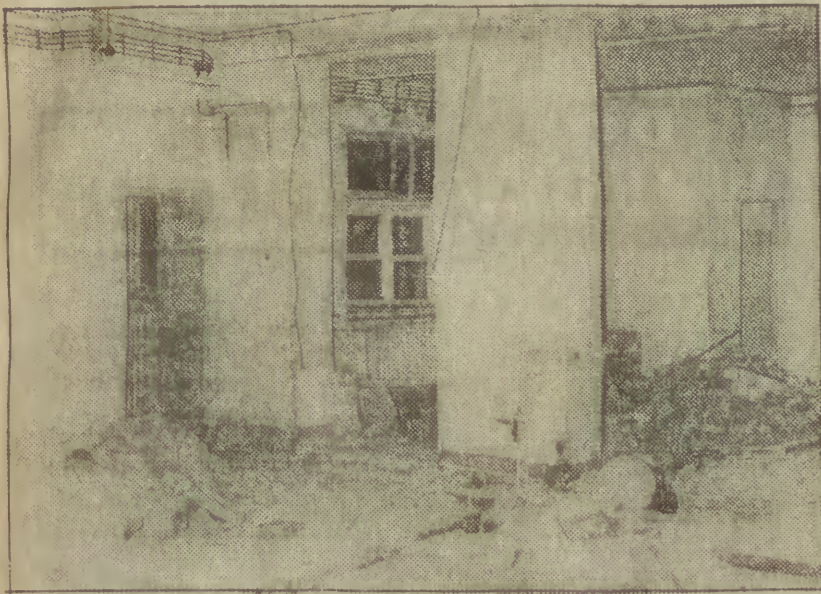
W „Ruczaju” pusto i... ciepło. Gdzie się podziela ekipa remontowa?
