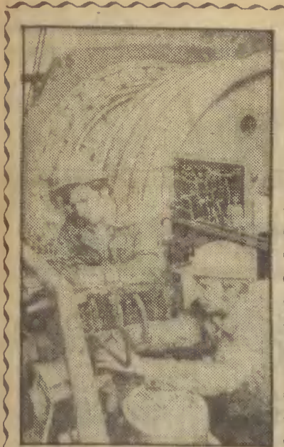
Trwa budowa kopalni węgla kamiennego w Suszczu-Zorach (woj. kawałki). Prace koncentrują się wokół szybu II - montuje się m. in. urządzenia wyciągowe. Urochomienie tego szybu pozwoli na rozwinięcie robót górniczych na dale. Na zdjęciu: ślusarz Jerzy Nicewicz i brygadziści Józef Urzoń montują maszynę wyciągową. CAF - Jakubowski
