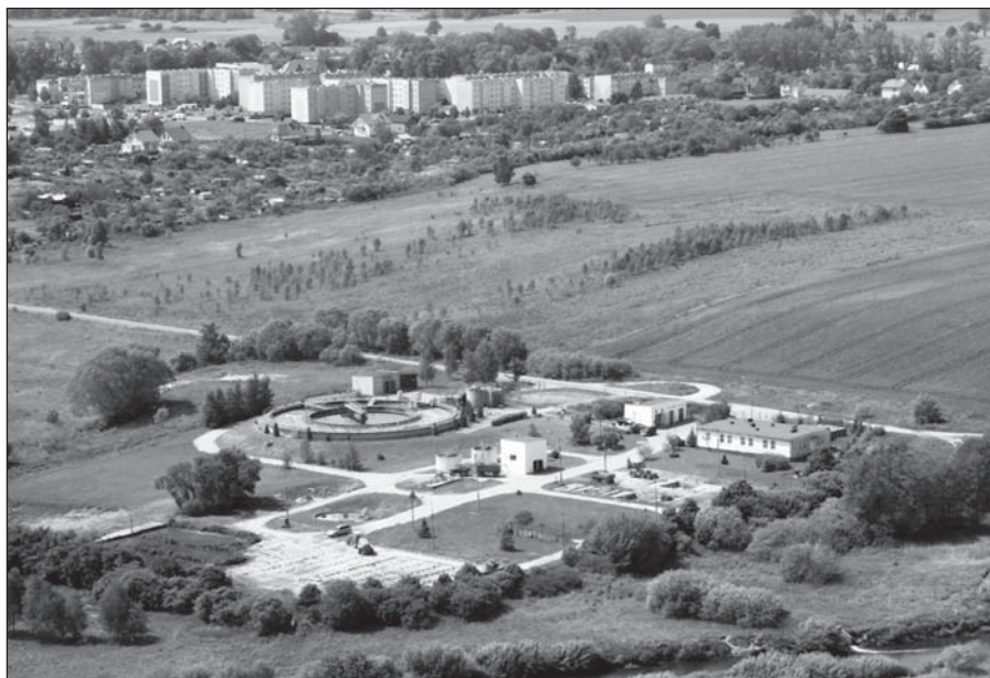
Oczyszczalnia ścieków – największa inwestycja komunalna w latach 90-tych XX wieku
