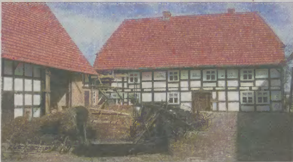
Swołowo, zagroda chłopska z budynkiem mieszkalnym.
