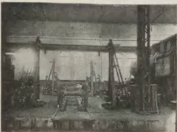
Ryc. 8. Widok na podnośnicę, umieszczoną w pierwszym trakcie pierwszej montowni parowozów warsztatów kolejowych we Lwowie.
