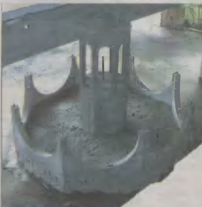
Jeden z detali architektonicznych, też we wstępnej fazie budowy.
