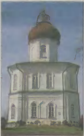
Cerkiew – latarnia na Siewierj Górze.
