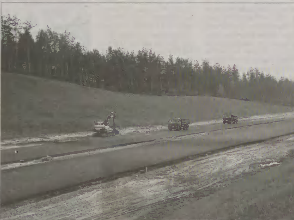
Na budowie odcinka autostrady A1 z Gdańska do węzła Swarżyn, październik 2006 r.
