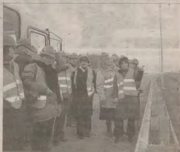
Społeczni inspektorzy pracy na budowie autostrady A-1
