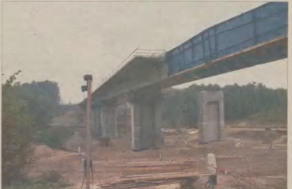
Przy budowie autostrady A1 stosowane są najnowocześniejsze technologie.
