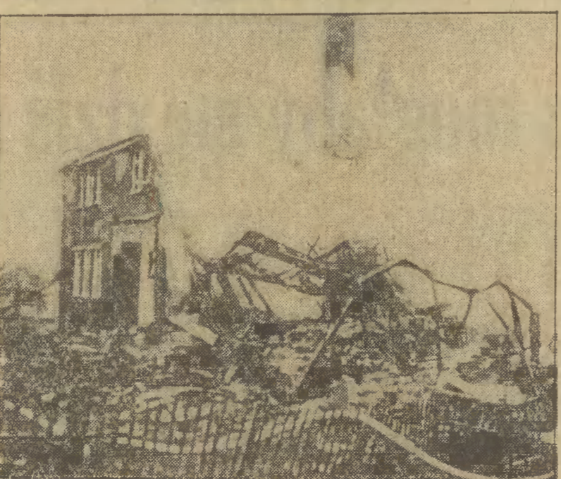
5 bm, w Glasgow (W. Brytania) nastąpił wybuch w jednym z domów mieszkalnych. Budynki ulegały całkowitemu zniszczeniu.
