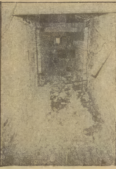
Jeszcze budowa czy już ruina?
