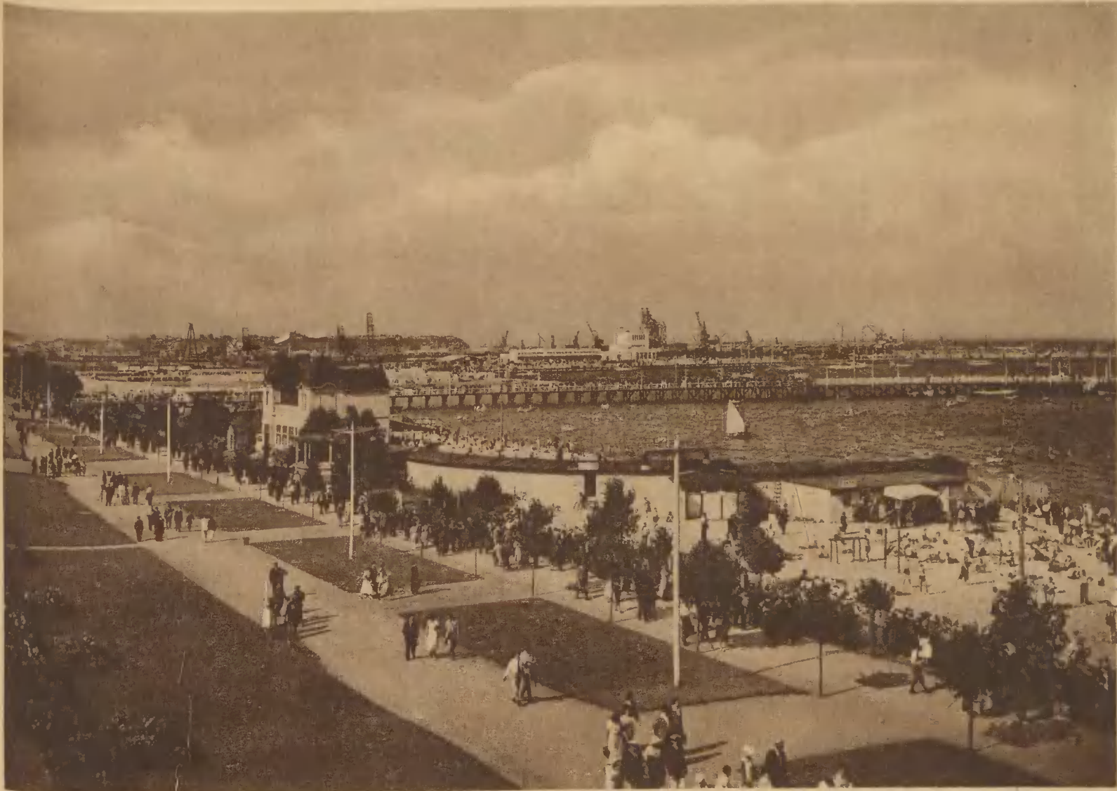
BULWARY, PLAŻA I WIDOK NA PORT.
