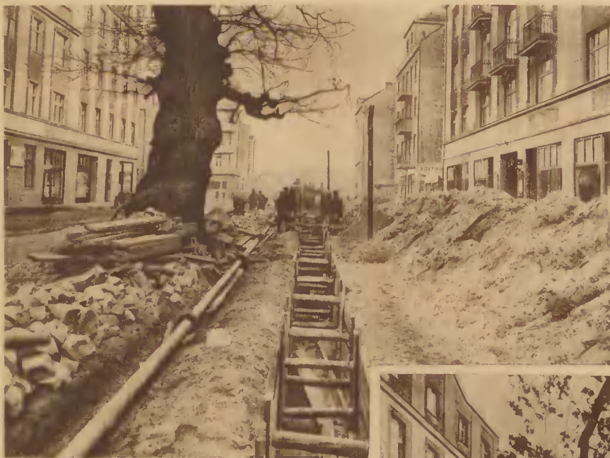
ZAKŁADANIE KANALIZACJI NA UL. PORTOWEJ.
