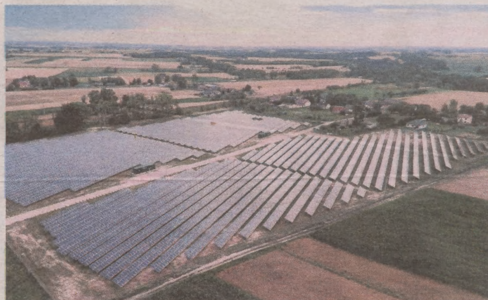
▶ Nowa elektrownia fotowoltaiczna Energi zajmuje powierzchnię ponad 24 tys. metrów kwadratowych
