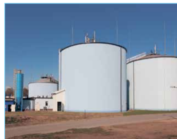
Oczyszczalnia ścieków w Słupsku – nowo wybudowana IV komora fermentacyjna
