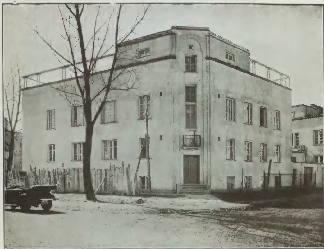
Jeden z domów na kolonji Konarskiego w Warszawie.
