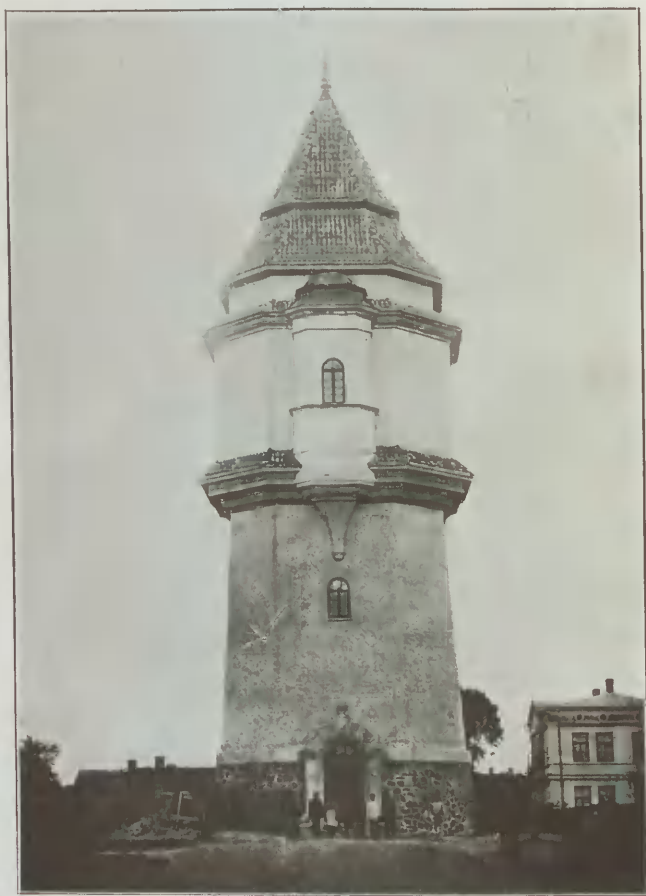
Wieża ciśnień w Tłuszczu.
