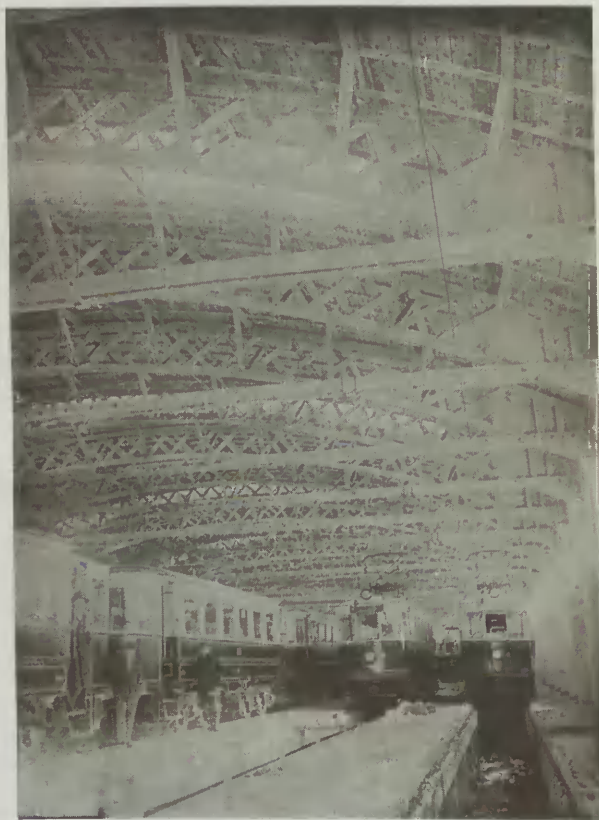
Wnętrze remizy tramwajowej E. K. D. z uwzględnieniem przekrycia dachowego syst. Polstefan.
