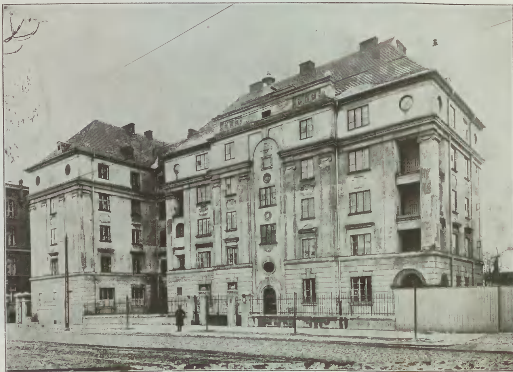
Dom administracyjny przy szpitalu wojskowym im. Marszałka Piłsudskiego w Warszawie przy ul. Nowowiejskiej.
