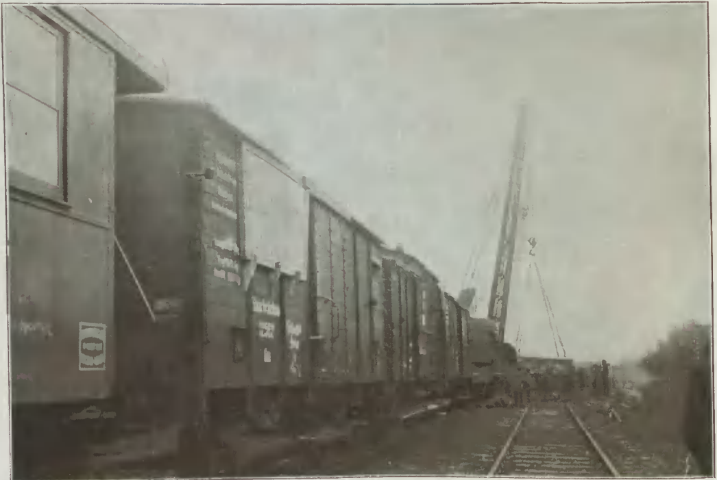
Pociąg rozwożący mosty betonowe z żurawiem dla ich ustawiania w Wileńskiej Dyr. P. K. P.
