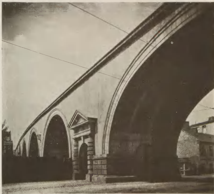
Wiadukt do nowego mostu kolejowego przez Wisłę, budowany wspólnie z firmą K. Rudzki i S-ka.
