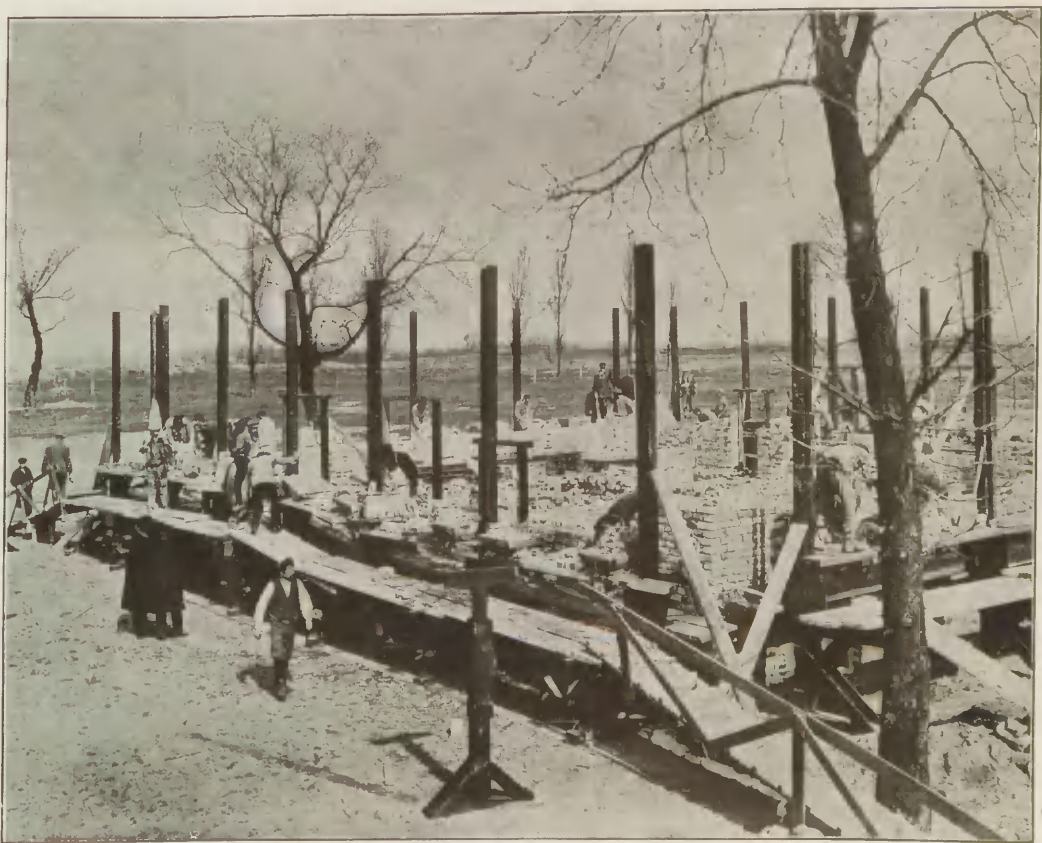
Rusztowania ruchome przy budowie Kolonji Magistratu st. m. Warszawy na Burakowie.
