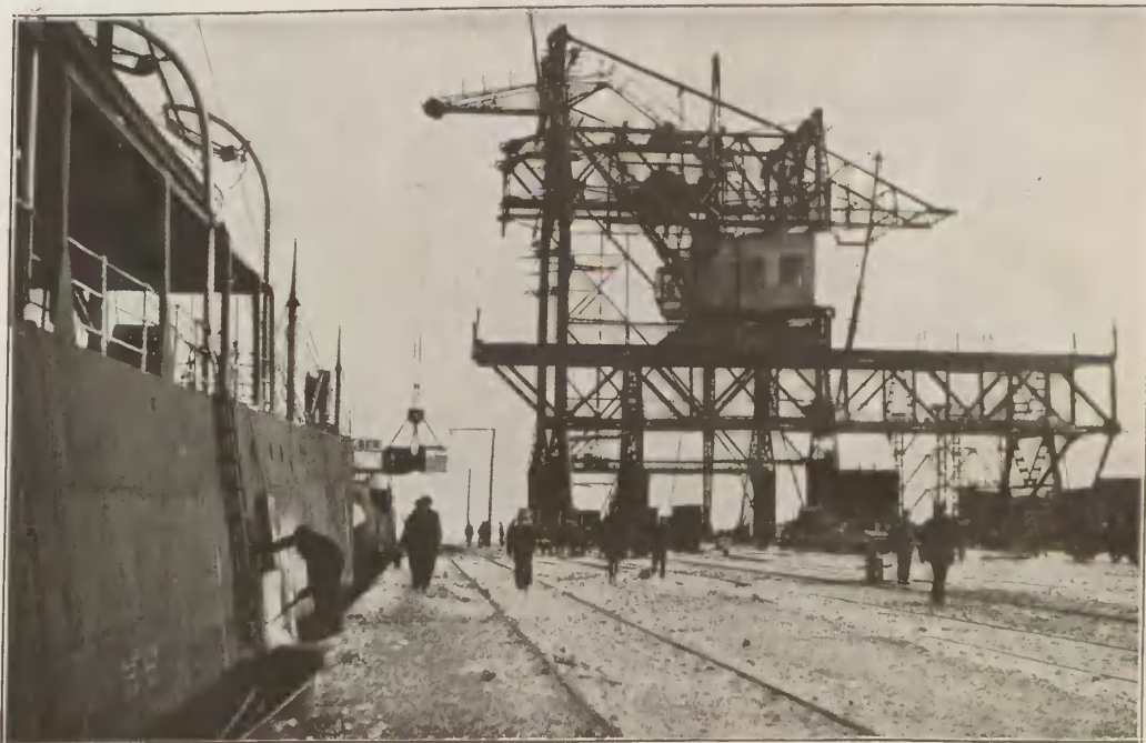
Fundamenty pod krany dźwigowe w porcie Gdynskim.
