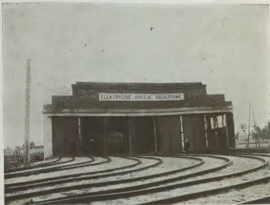
Remiza tramwajowa Elektrycznych Kolei Dojazdowych w Grodzisku.
