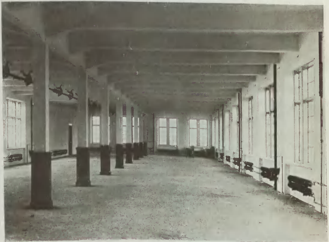
Wytwórnia Sprawdzianów w Warszawie przy ul. Duchnickiej 3. Sala maszyn.
