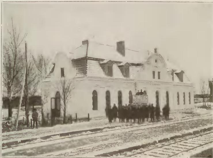
Dworzec P. K. P. w Bohdanowie.
