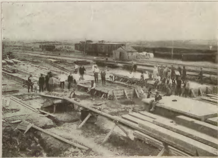
Budowa płyt żelbetowych dla mostów w Wileńskiej Dyrekcji P. K. P.
