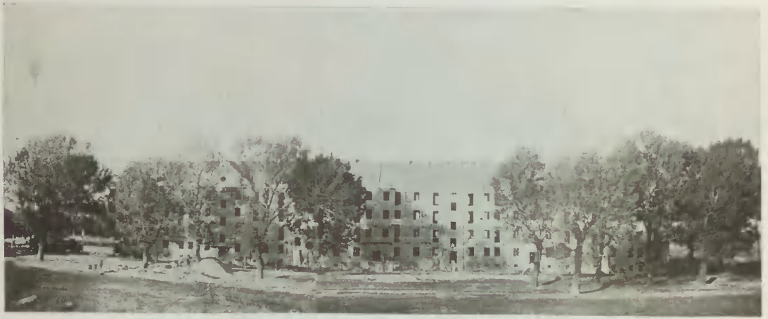
Dom Spółdzielni Mieszkaniowej Urzędników Państwowych w Warszawie przy ul. Marymonckiej.
