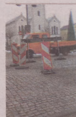
► Drogowcy uzupełnili brakującą kostkę brukową
