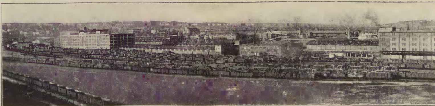
Vue générale sur les magasins de première ligne du quai de Pologne.
