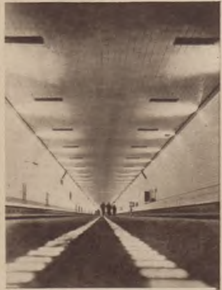
Na zdjęciu: widok wewnętrzny otwartego ostatnio ogromnego tunelu pod rzeką Hudson w Nowym Jorku (Stany Zjednoczone).
