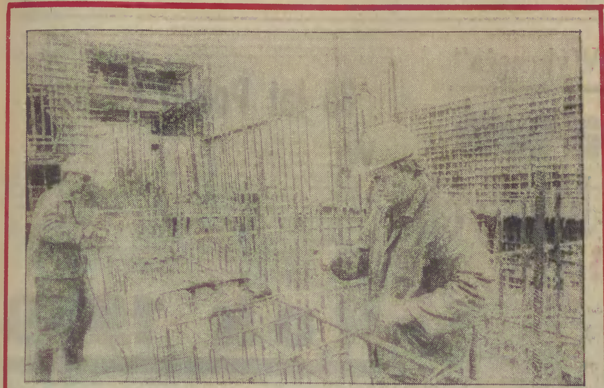
Trwa budowa elektrowni szczytowo - pompowej nad Jeziorem Zarnowieckim. Będzie ona posiadać 4 bloki o mocy 170 MW każdy. Pierwszy turbozespol powinien dać prąd w 1980 roku.
