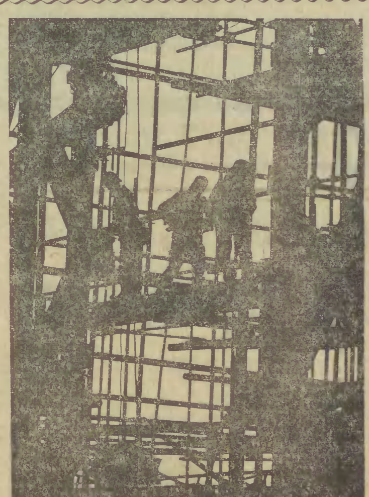
Montaż rusztowań na jednej z jednostek budowanych w Stoczni Gdańskiej im. Lenina. Fot. M. Zarzecki
