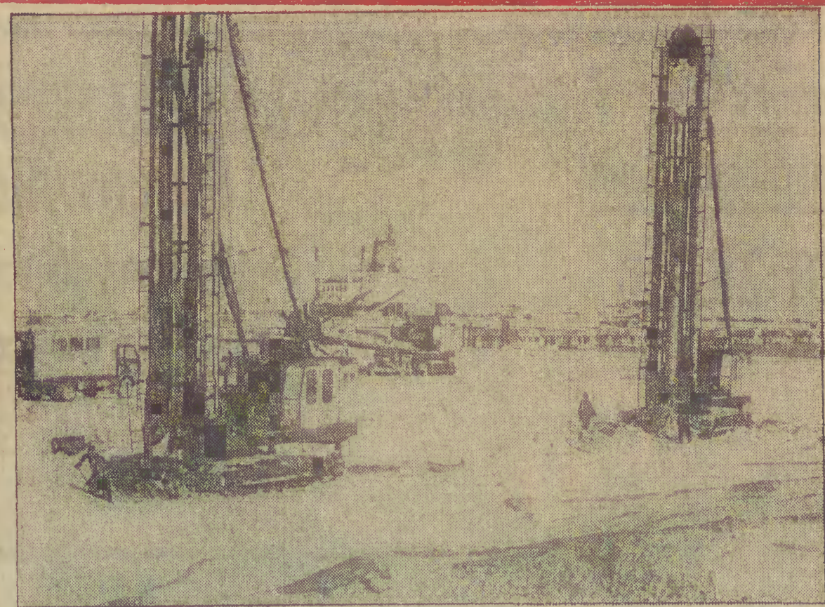
Pomimo utrzymującej się mroźnej pogody prace przy budowie bazy rudowej na terenie Portu Północnego nadal nieprzerwanie trwają.
