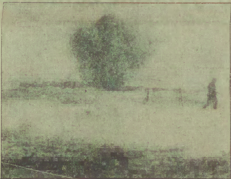
Na Odrze koło Katowic saperzy rozpoczęli kruszenie lodu materiałami wybuchowymi, by uchronić istniejący tu jaz przed zniszczeniem zatorów lodowymi.
