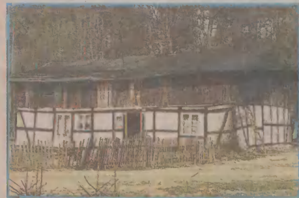
Dom o konstrukcji szachulcowej z miejscowości Kamienna Góra pod Mirachowem. Starsi mówią, że w takim domu było więcej ciepła, przede wszystkim rodzinnego.
