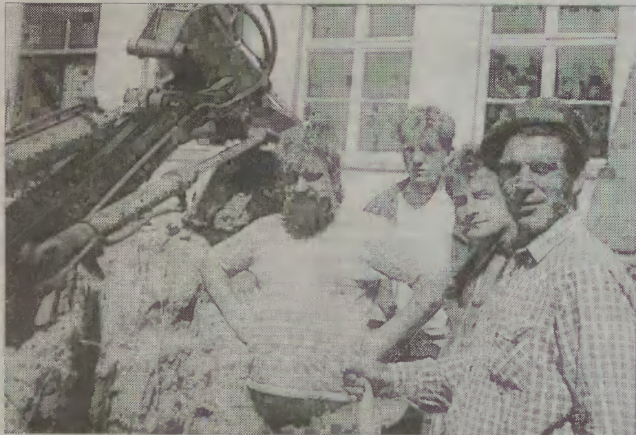
Mieszkańcy Cieczewa ofiarnie pracują przy budowie szkoły
